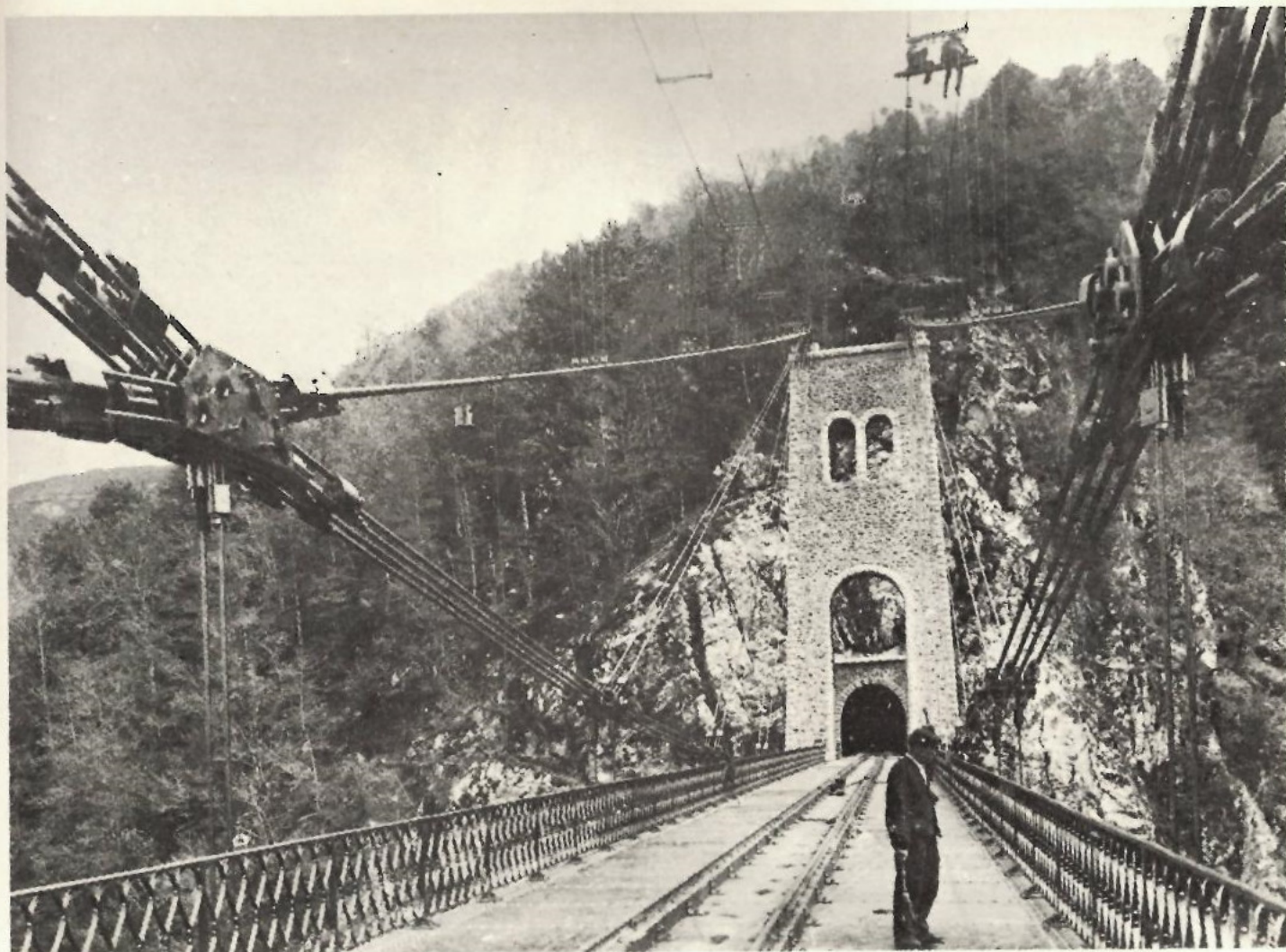
Sur le viaduc suspendu au droit des nœuds d'articulation des fermes.
